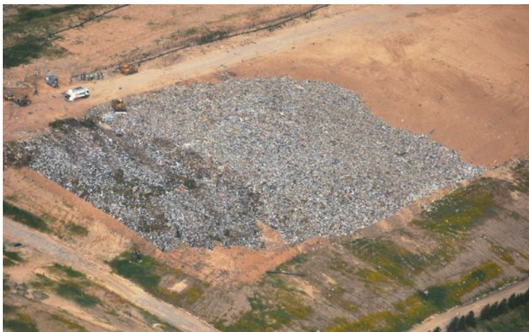
Aspecto del relleno sanitario de la CEAMSE en enero de 2013
