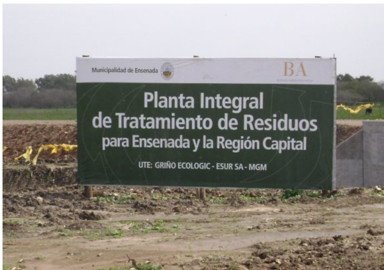
Entrada al predio donde se construye la Planta de Tratamiento de Residuos
