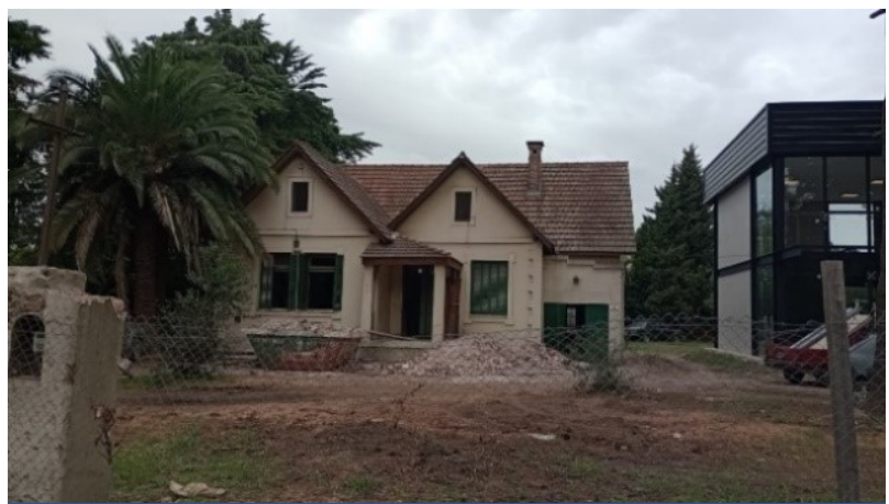
Foto: fuente DNI, demolición Cno. Gral. Belgrano
