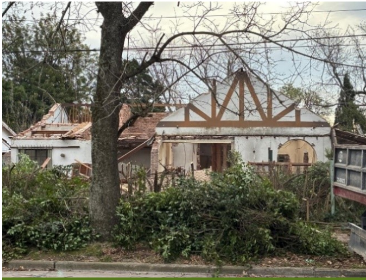
Foto: fuente DNI Demolición Calle 473 bis entre 15a
