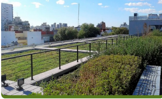
Terraza Edificio Comuna 12 – GCBA, CABA
